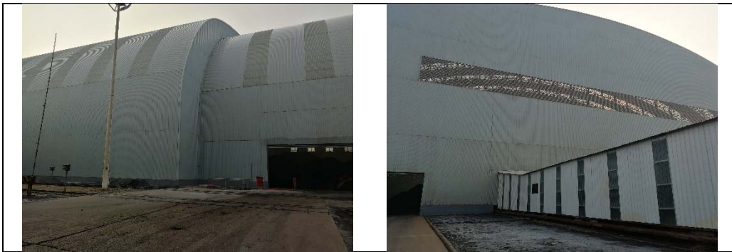
原料场封闭建设情况
