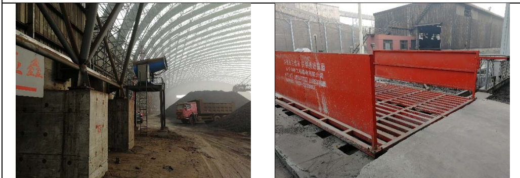
雾炮器与洗车台
